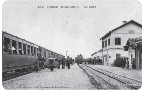
Hình 5. Nhà ga xe lửa tại Hải Dương do Pháp xây dựng
