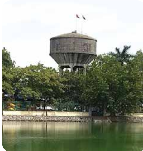
Hình 11. Tháp nước tại thành phố Hải Dương
